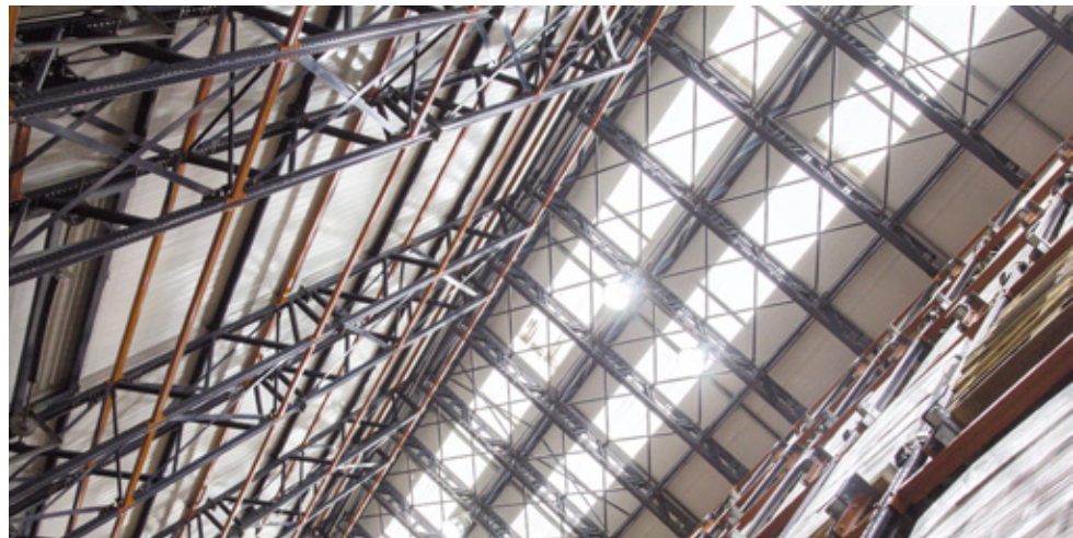
Imágenes de un depósito autoportante dedicado a almacenar productos a temperatura ambiente.
