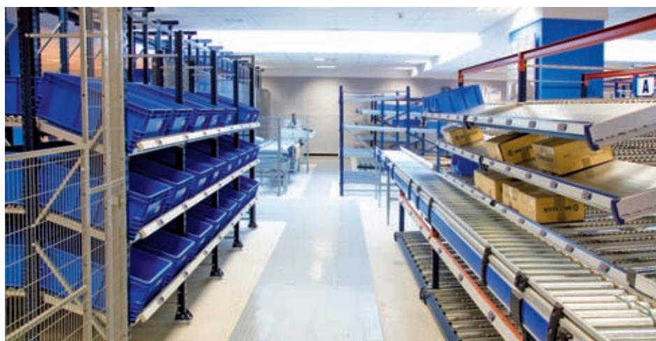
Instalación de dispositivos pick to light.
